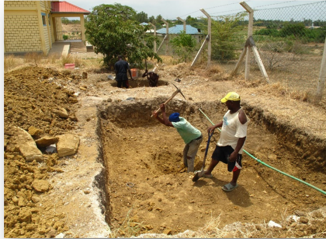
Zurzeit heben Arbeiter die Klärbecken für die autarke Abwasseranlage der Klinik aus
