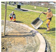
Mitarbeiter des Bauhofs bei Arbeiten am neuen Baumgrabfeld. FOTO: RE
